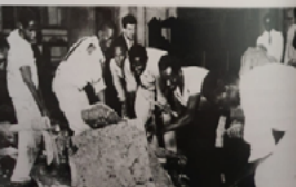
Início da demolição 1933
